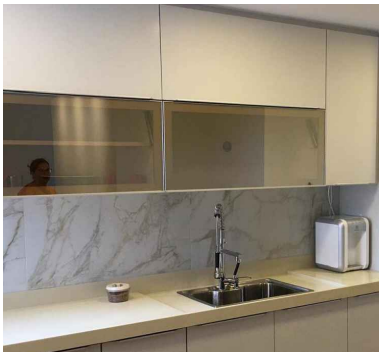
DETALHE 01: VIDRO REFLECTA BRONZE 10mm
